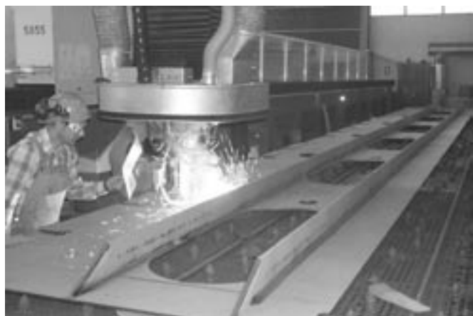
Figur 3. Vid Odense Steel Ship Yard svetsar man 240 m profiler på 3 tim med laserhybridsvetsning.
