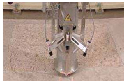
Figur 34. Lasertechnik används för såväl särtagning av kontaminerade rör, där vi ser verktyget "LaserSnake" i sin fulla längd t.v., men också vid avverkning av det förorenade ytskiktet hos betong med det specialutvecklade verktyget t.h.
