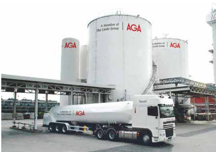
Bild 2. Luftseparationsfabrik med förvaringstankar. Destillationskolonnen till höger på bilden.
