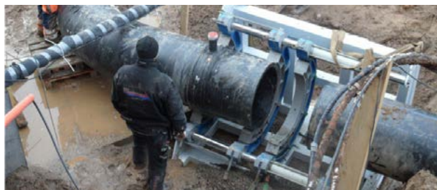
Plastsvetsning av avloppsrör.
